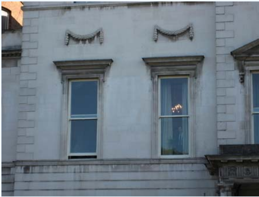
在爱尔兰，中方人员在楼上偷望马路对面的抗议队伍和横幅。（李凌云/大纪元）
